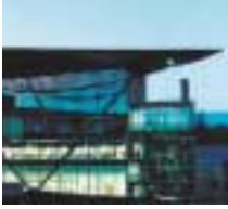
Met Office exterior
